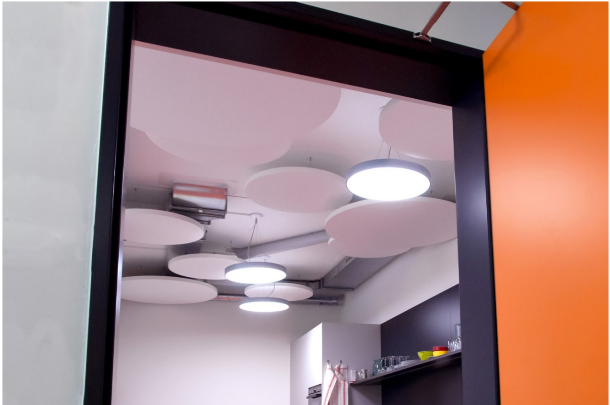
Akustische Überlegungen laufen bei der Planung immer mit. Im Teamzimmer kaschieren die «Bubbles» an der Decke die Leitungsinstallationen und schlucken gleichzeitig den Schall.
