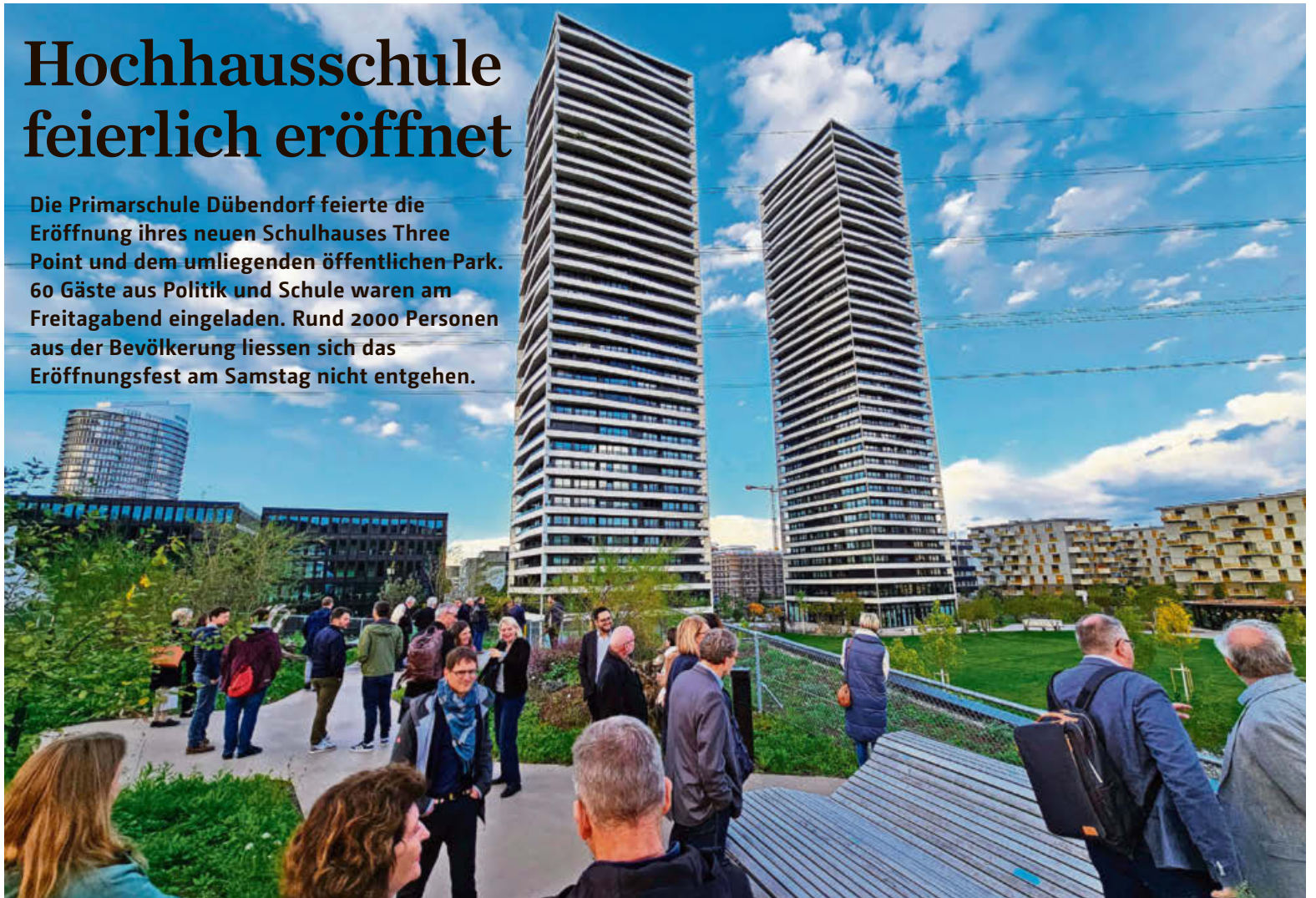
Die Fläche auf dem begrünten Turnhallendach lädt zum Verweilen ein.
